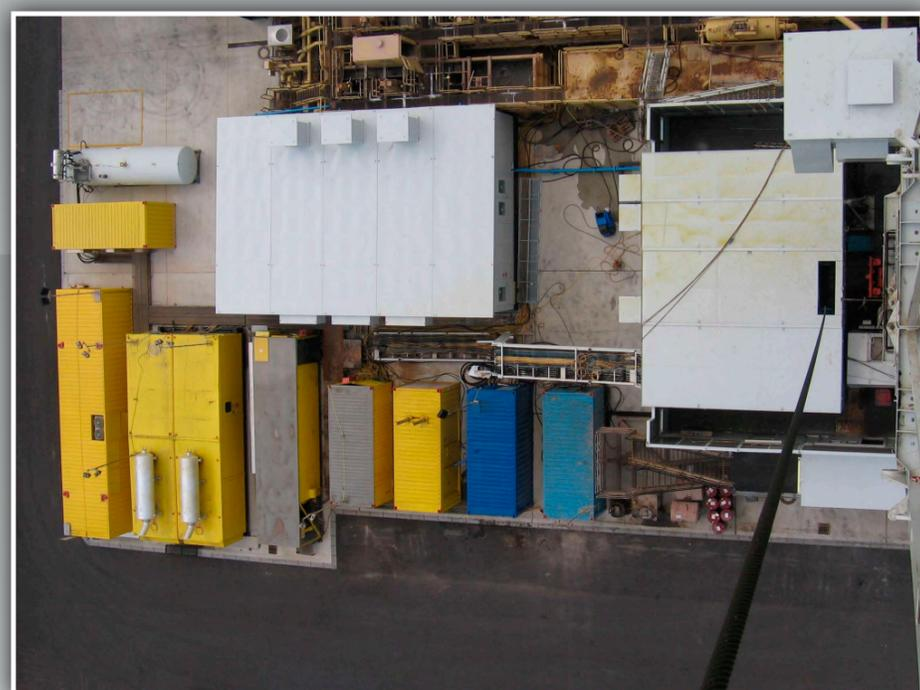
Schallschutzhaus für drei große Blower mit Zuluft- und Abluftschalldämpfern.
